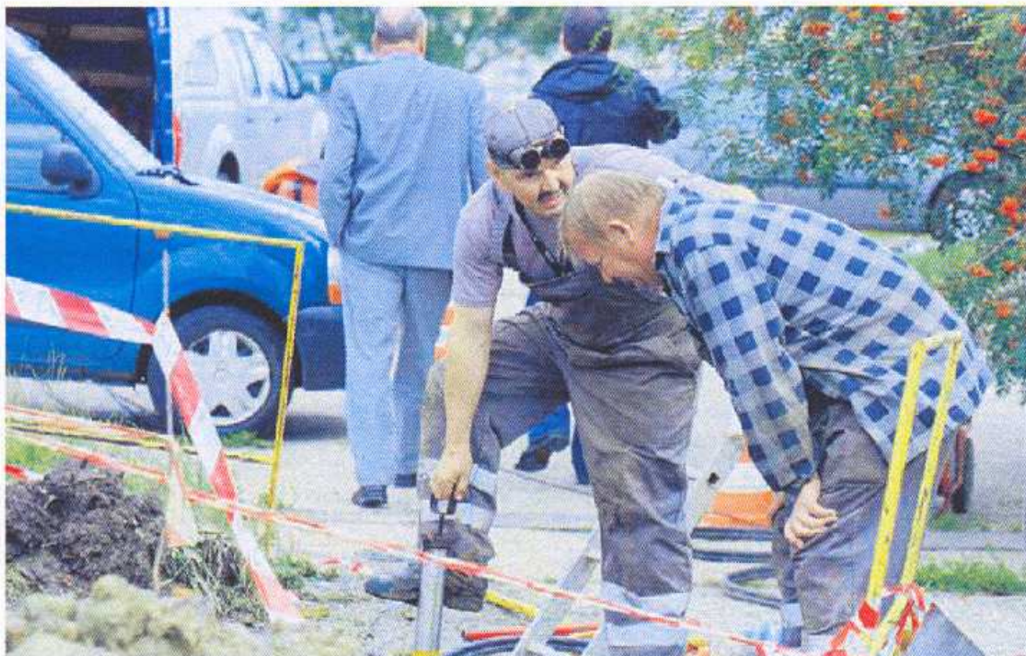
Kilkadziesiąt godzin robotnicy naprawiali awarię gazociągu w wałbrzyskiej dzielnicy Podzamcze
