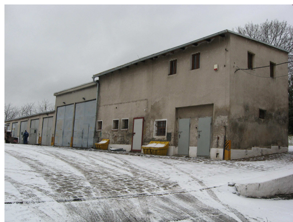
Widok na ciąg budynków garażowo- magazynowo- warsztatowych
