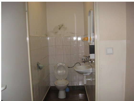
Widok na w.c.
