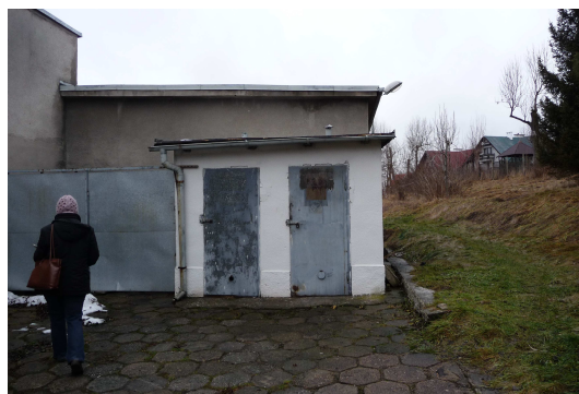
Widok na 2 pomieszczenia dobudowane do
