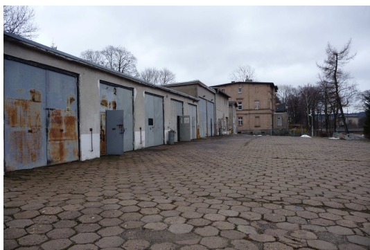
Widok na budynek i plac manewrowy budynku.
