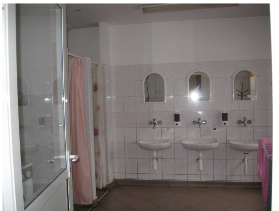
Widok na pomieszczenie sanitarne
