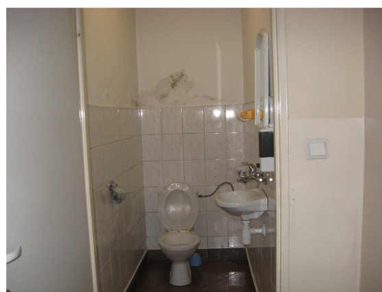
Widok na w.c.
