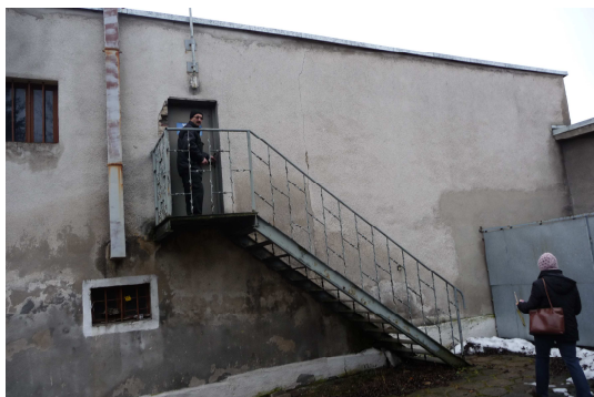
Wejście na piętro budynku budynku
