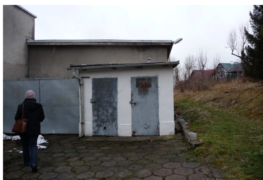
Widok na 2 pomieszczenia dobudowane do
