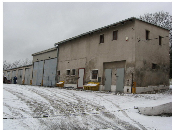
Widok na ciąg budynków garażowo- magazynowo- warsztatowych
