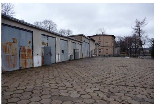
Widok na budynek i plac manewrowy budynku.
