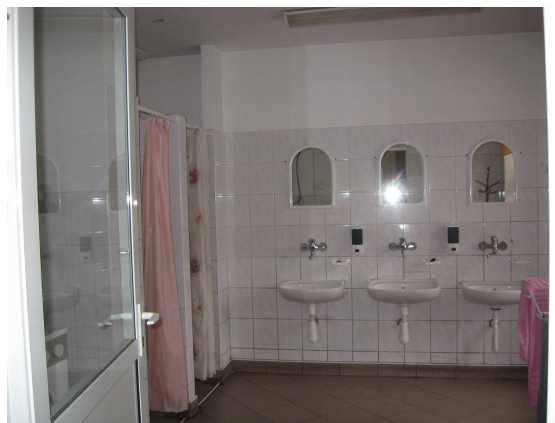
Widok na pomieszczenie sanitarne
